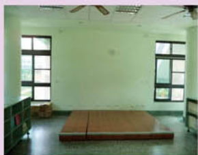
▲施工前圖書室缺乏整體規劃
